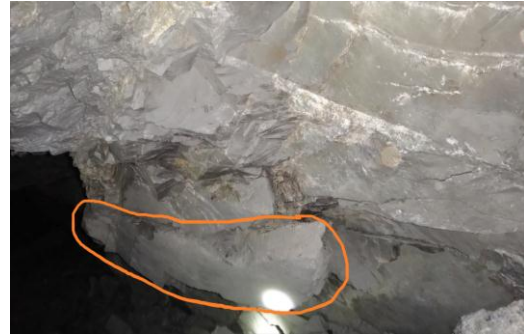
图 2-2 采场顶板浮石
